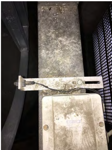
Näherungsschalter, als Hilfsmessung, da das Messprinzip des Motorsensors nicht genügend zuverlässig ist.
