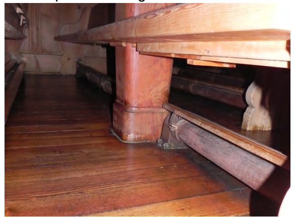
Fussschemelheizung Schiff
