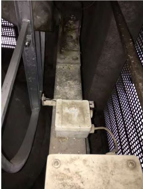
Glocke 1 mit Steuerschalter direkt auf Glockenstuhl
