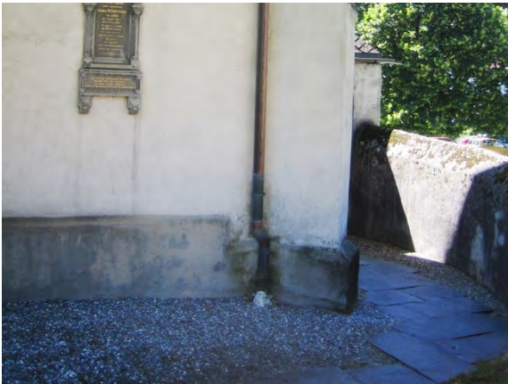
Sockel / Feuchteschäden
