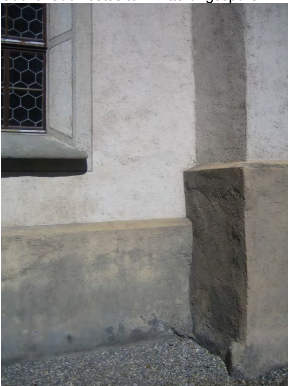
Sockel / Verputzschäden
