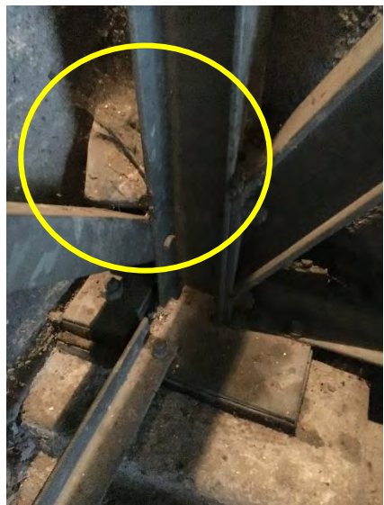
Eckpfosten in der NW Ecke mit verklemmtem Stein
