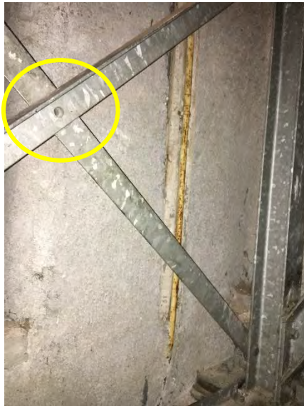
Andreaskreuz mit fehlender Schraube (b. Aufgang)
