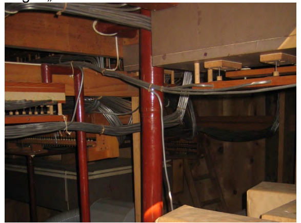
Unterbau Orgel / Leitungen
