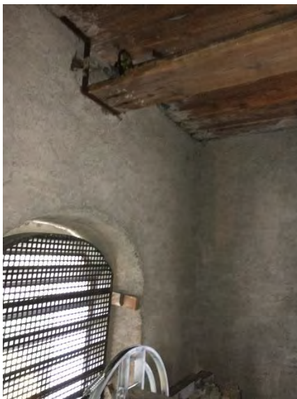
Joch der kleinsten Glocke als Standplatz für Wartung des Zeigerwerks Nord.
