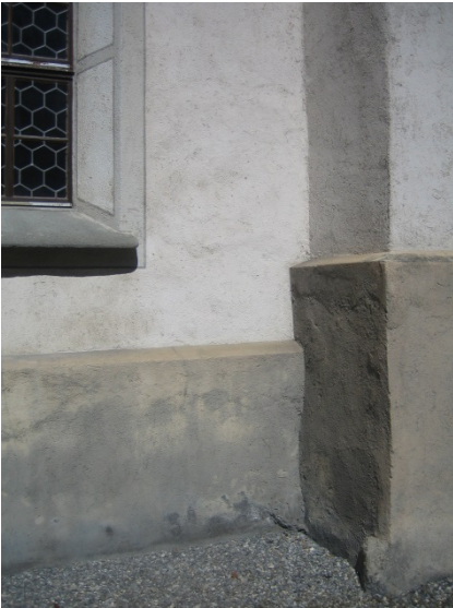
Sockel / Verputzschäden
