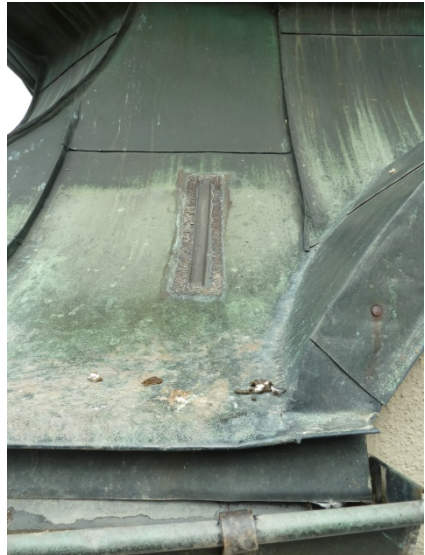
Flickstelle Dach Turm
