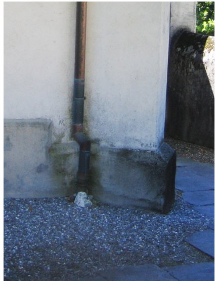
Sockel / Feuchteschäden
