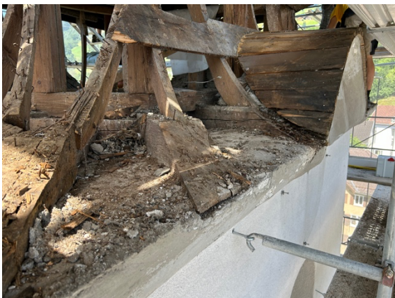
Reparaturen Dachstuhl/Schalung Zwiebel
