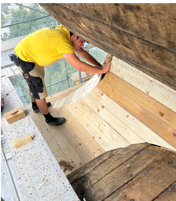
Erneuerung Dachschalung Zwiebel
