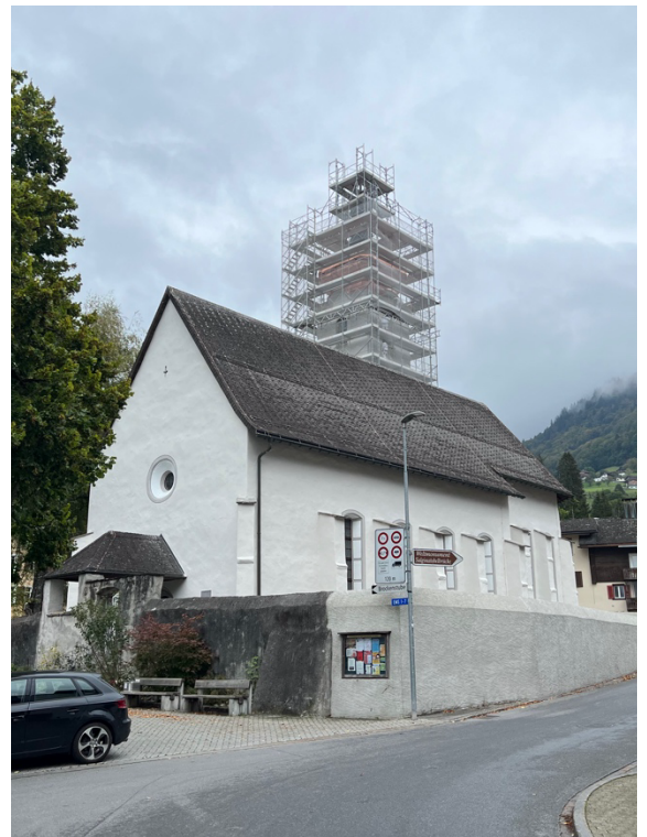
fertiger Fassadenanstrich Kirche
