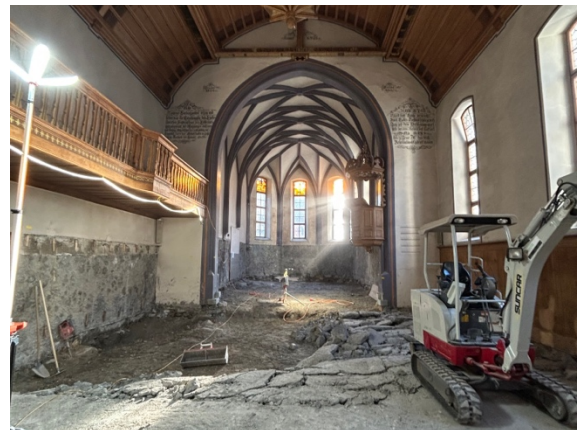
Rückbau Bodenplatte
