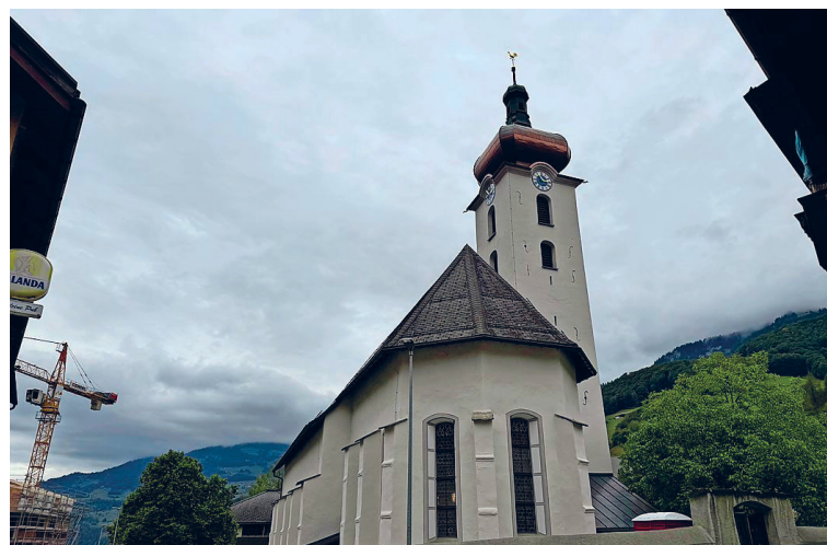
Die reformierte Kirche in Schiers wurde saniert.
